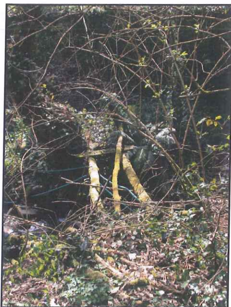
Percorso storico- il ponte
